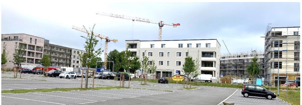
Abbildung 9: Baufortschritt im Trapezblock, links das fertiggestellte Gebäude auf dem Pioniergrundstück an der Immanuel-Kant-Straße (Quelle: NRW.URBAN, Stand Juli 2025)
